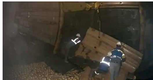
ANTES: La cuadrilla estaba expuesta a múltiples peligros cuando se eslingaban las corazas de manera manual
