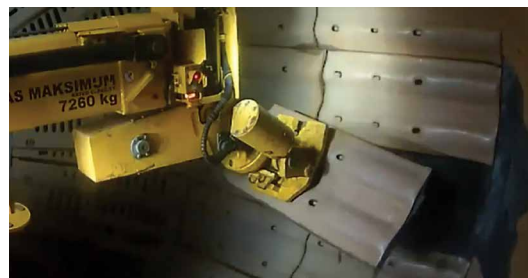
DESPUÉS: Los revestimientos desgastados se sacan de la pared del molino sin miembros de la cuadrilla en el interior
