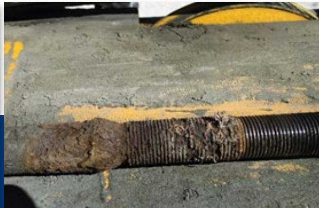
Figura 3: Corrosión en el tensor crimpado del cable de la pluma de la MRM debido a prácticas inapropiadas al almacenar la MRM.
